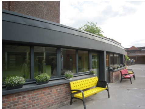
Le nouveau bloc sanitaire de l'école Saint Louis
